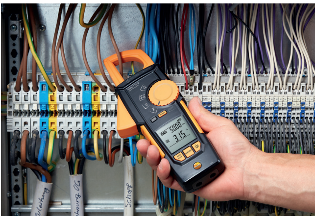
Kapcsolószekrény áramerősség mérése.
