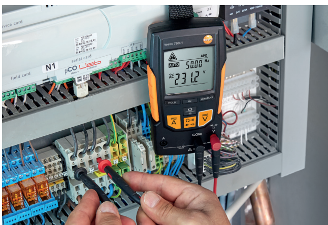
Hőszivattyú kapcsolószekrényének feszültség vizsgálata.
